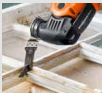
Restauro di vecchie finestre.
