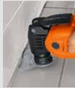
Rimozione di sigillante elastico per fughe.
