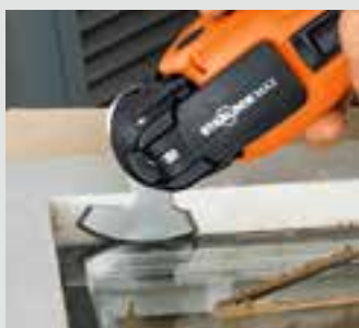
Taglio di vetri isolanti fissati con mastice.
