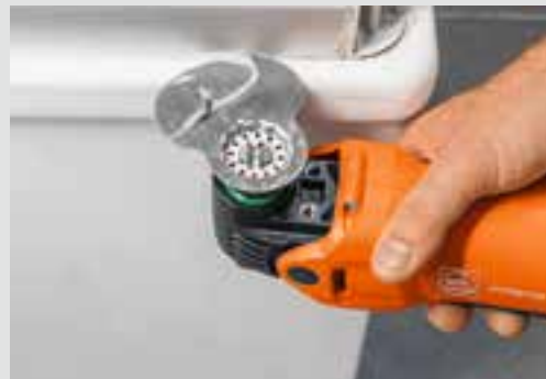
Rimozione di giunti elastici.
