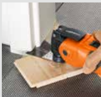
Infissi accorciati perfettamente.
