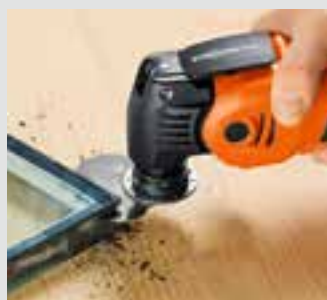
Distacco di vetri isolanti.
