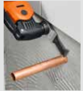
Taglio a filo con la parete negli spazi ristretti.
