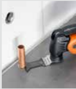
Facile rimozione di vecchi impianti.
