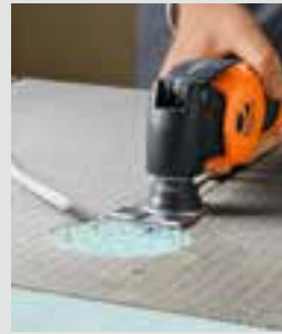
Preparazione dell'installazione di impianti elettrici.
