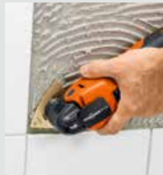
Raspare in piano il collante per piastrelle.
