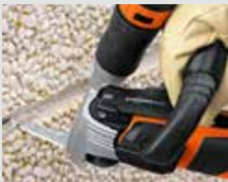
In caso di materiali pericolosi utilizzati nelle fughe (per es. PCB) si usa l'aspirazione della polvere.
