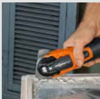
Senza rischiare di rompere il vetro grazie al movimento ad oscillazione.
