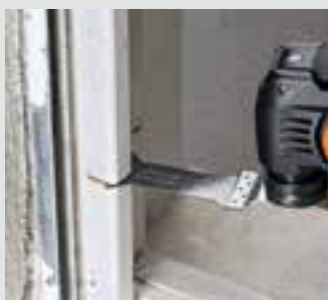
Taglio di telai di finestre.
