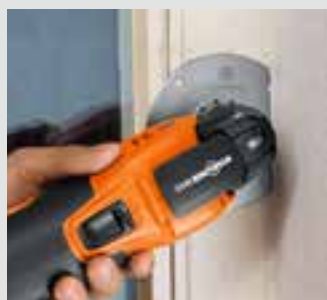
Taglio di nastri di rinforzo metallici durante lo smontaggio di vecchie finestre.
