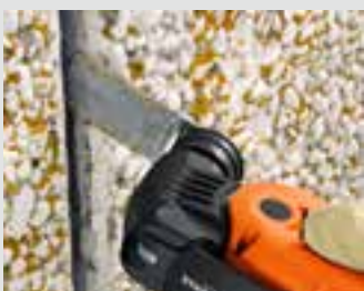
Irruvimento dei fianchi dei giunti prima di rinnovarli.
