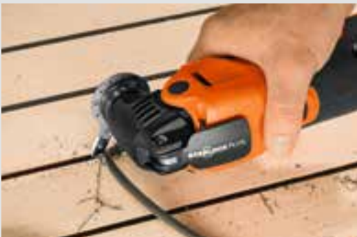
Risparmio di tempo di fino all'80% per la sostituzione di doghe di legno in teak.
