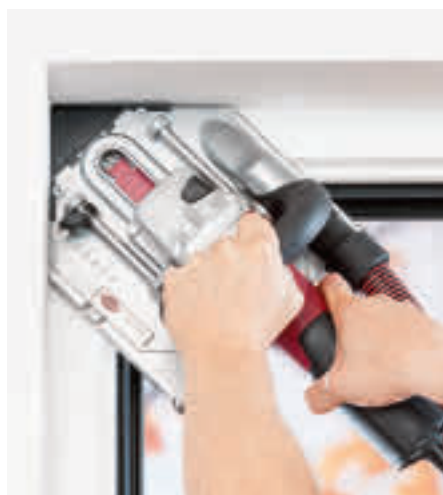
Taglio nella spalletta del vano finestra
