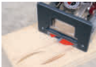
Lavorazione aggiunta: Riparazione legno
