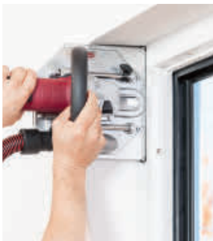
Taglio nel telaio in legno
